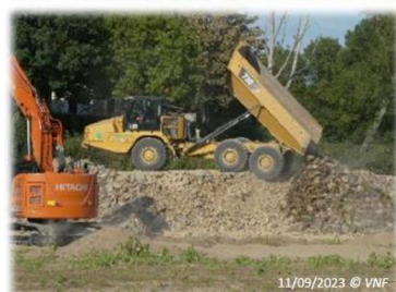
Mise en stock des plus gros enrochements pour reprise...
