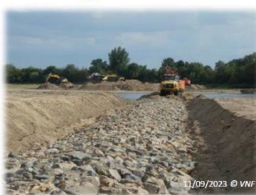
Ouvrage abaissé, raccourci
