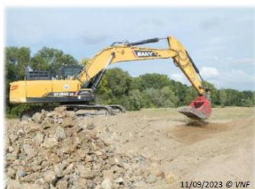
Tri des matériaux pour ne laisser que le sable
