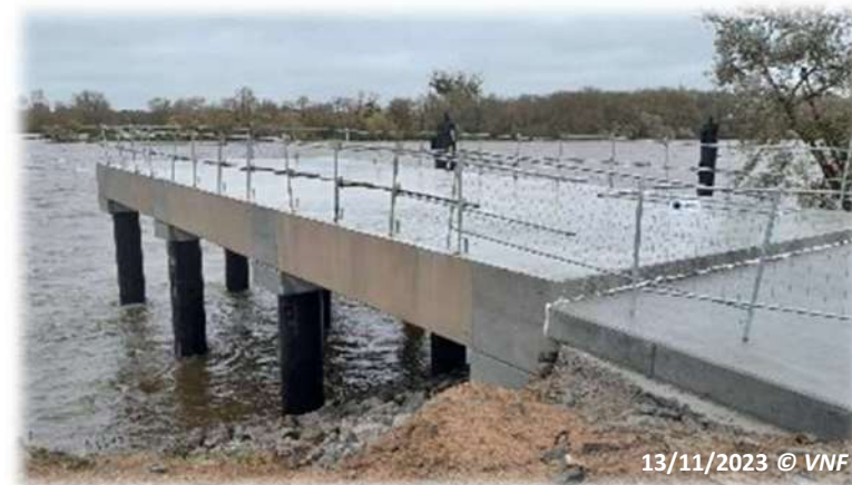
Estacade de l'officière (st Julien-de Concelles)
