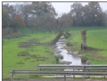
Linéaire restauré en aval de la D95
