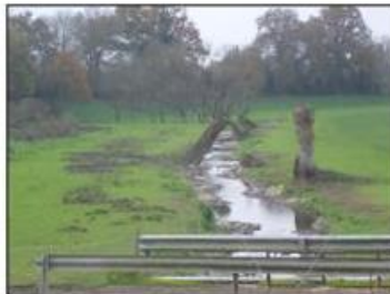
Linéaire restauré en aval de la D95
