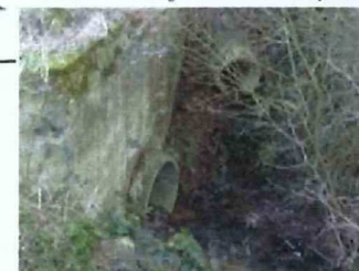
exutoire 1 : busage sous la VC n°93 Ø1200
