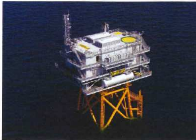
Figure 4 : Poste électrique en mer du parc éolien Dong Energy de Walney
